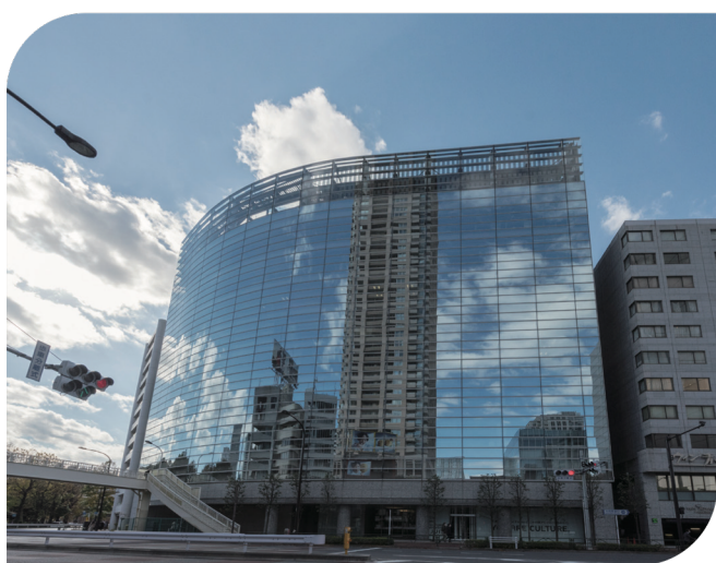
ヒューリック青山外苑東通ビル
